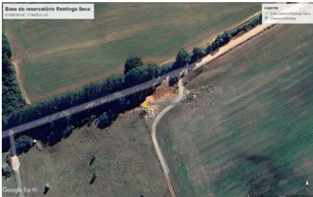
Base do reservatório da Comunidade Restinga Seca, onde será instalada escada, cerca e portão.
